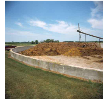
Photographie d'une structure d'entreposage des fumiers. Photo : Ontario photothèque agriculture
